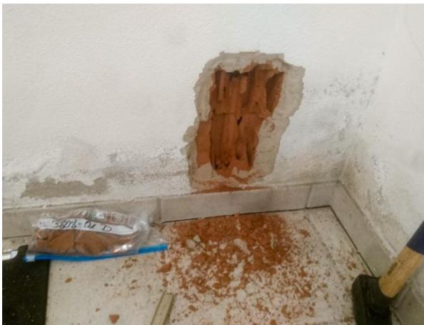
**Abb.4a: Bauteilöffnung Mauerwerk, Material manuell gestemmt.**
