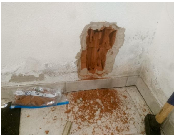
Abb.4a: Bauteilöffnung Mauerwerk, Material manuell gestemmt.
